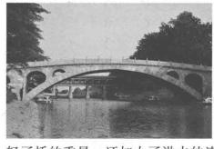
位于河北省赵县的赵州桥,建于1400多年前的隋代,是世界上第一座用石头建造的单孔拱桥,它的设计者李春是一位著名的工匠<sup>2</sup>。赵州桥的设计有许多独到之处:50多米长的赵州桥,桥面坡度不大,十分便于车马、行人上下;桥拱<sup>3</sup>两边有四个小拱洞,不但节省了石材,减
